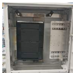
230448 F5 mit Muffe 3M BPEO Gr.2 auf 190580 Glasfasereinsatz
