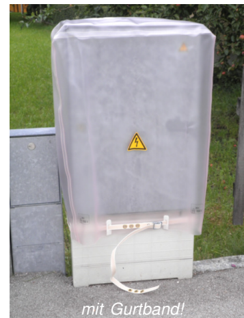
Freiluftverteilerschrank:
